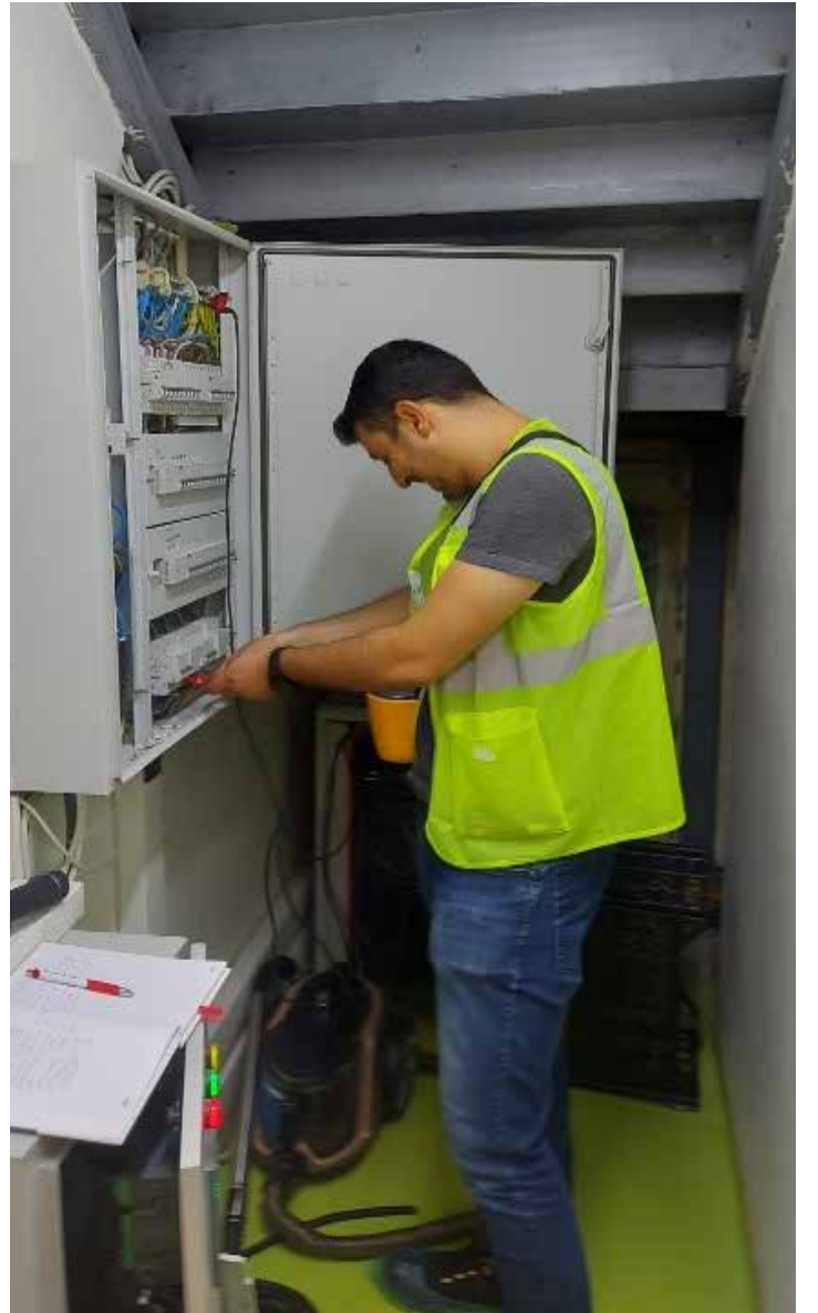
Şekil 11: İç elektrik tesisatı ve topraklama periyodik muayeneleri
